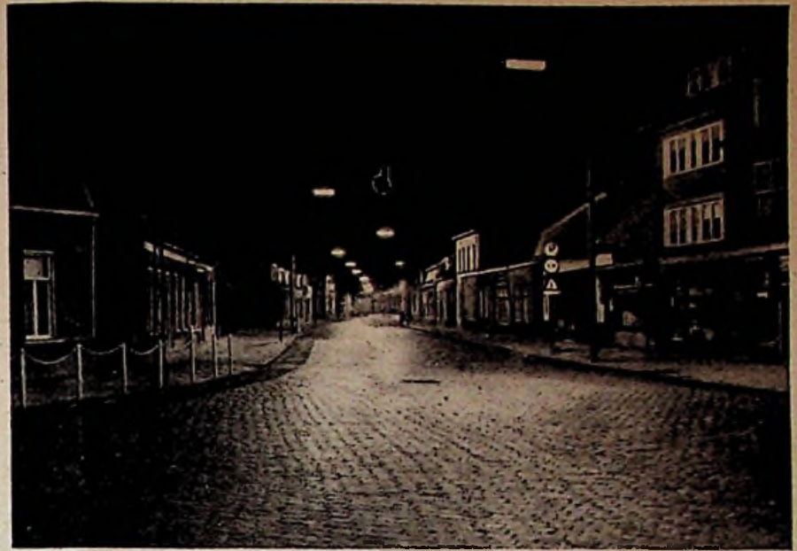
Moderne straatverlichting met fluorescentiebuisen
